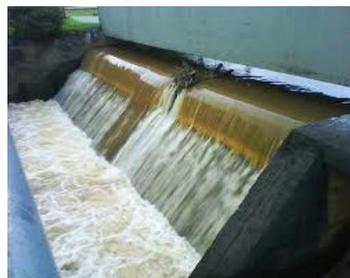
Fig.36 Vertedor com abertura retangular
