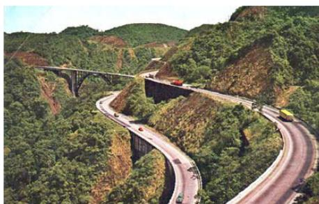
Fig. 31c – Curva Simples e curva reversa
