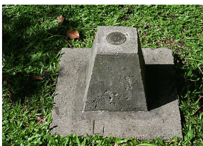
Figura 6.27 - Marco de concreto.
