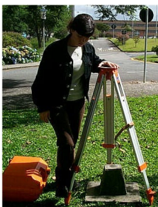
Figura 6.31 - Cravando o tripé no solo.
